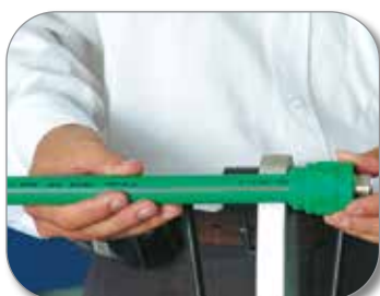
Bước 5: Nối các bộ phận cần hàn với nhau, không được xoay trong lúc nối Joint the pipe & the fitting by pushing the pipe until it reaches the mark, both parts must remain fixed, without rotation during the jointing time
