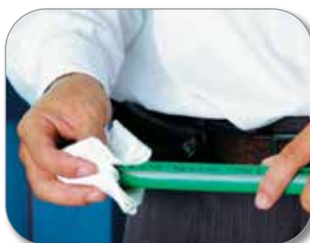
Bước 2: Lau sạch đầu ống để hàn Clean the pipe ends before to weld
